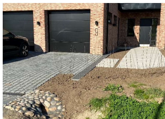
Eksempel på afledning af vand fra tagnedløb
